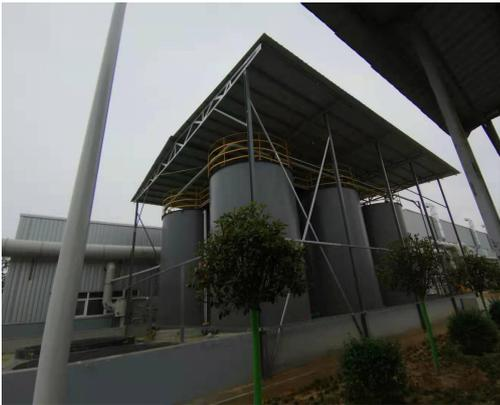
新建6个硫酸储槽，其中3个原料槽、3个成品槽
